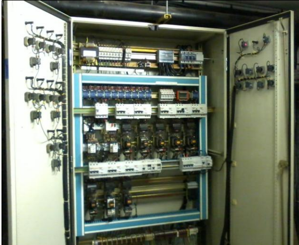
Armoire existante électrique de commande des pompes
